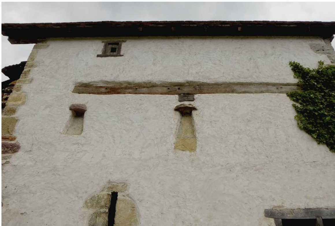
LADO SUR CON LOS PILARES Y RODEZNO EN MEDIO DEL REFORMADO HÓRREO.
