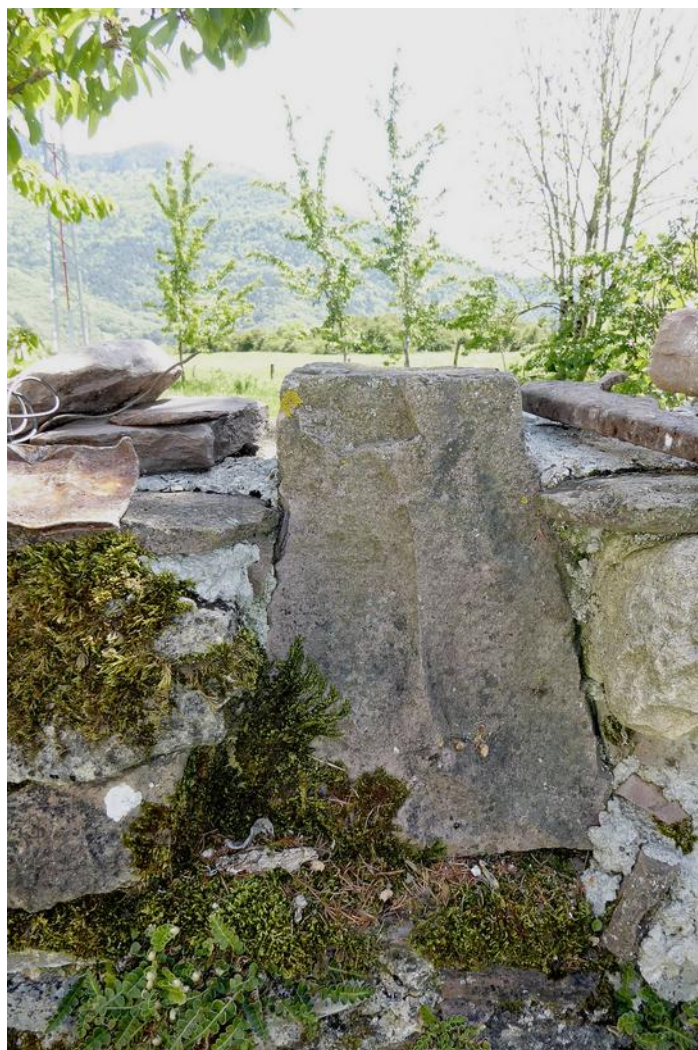
Pilar en su sitio.
